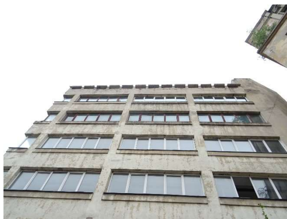
Clădire existentă - fațadă corp B Calea Victoriei nr. 220, nr. 216 și nr. 218, sector 1, București
