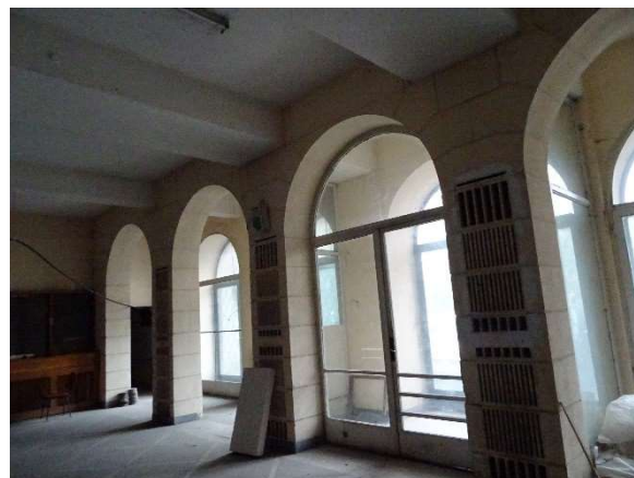
Clădire existentă - parter Calea Victoriei nr. 218, sector 1, București
